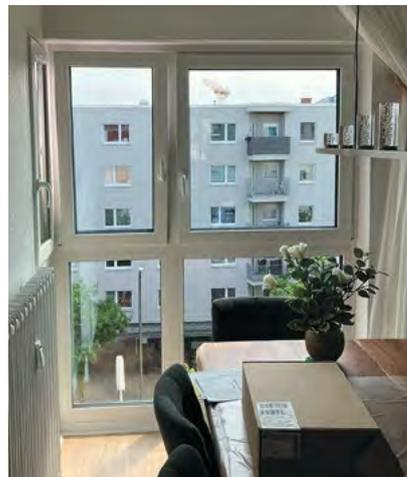
Mittlerweile wurden in den Wohnungen die Bestandsfenster durch hoch-effiziente Wärmeschutzfenster mit 3-fach-Verglasung und teilweise einem erhöhten Schallschutz ausgetauscht. Die Arbeiten in den Wohnungen wurden Ende September 2023 abgeschlossen.
